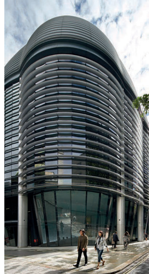
THE WALBROOK in London mit Fassadenelementen aus glasfaserverstärktem Kunststoff.
