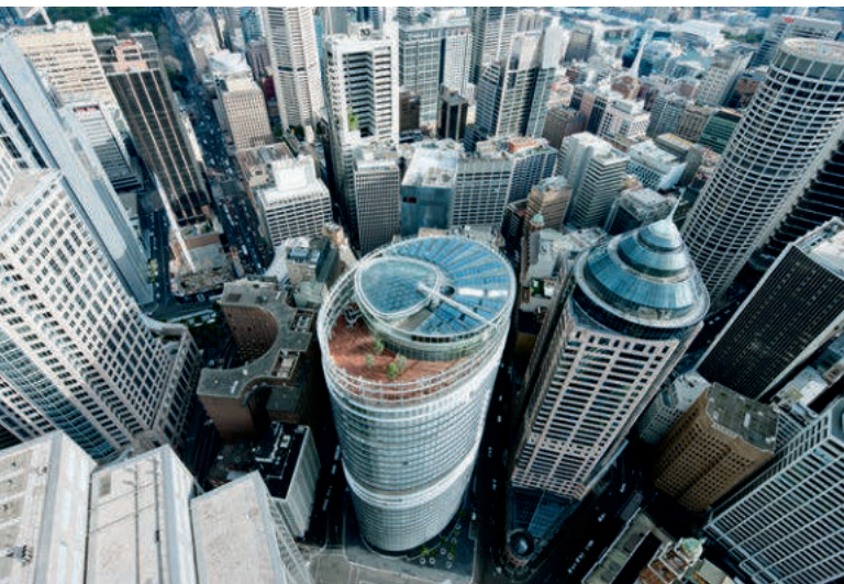
EIN ATRIUM von 139 Meter Höhe sorgt im gläsernen Hochhaus »I Bligh« in Sydney von Stararchitekt Christoph Ingenhoven für natürliches Raumklima in allen Etagen.
